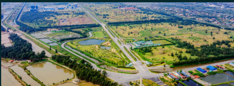
Toàn cảnh Khu công nghiệp Dệt may Rạng Đông - Aurora IP
